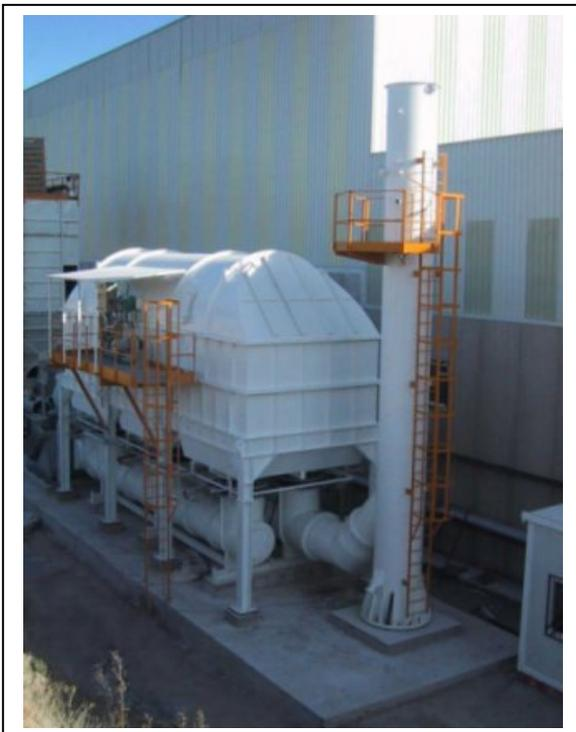
entrar en la cámara de combustión, donde se quema el gas destruyéndose así los vapores orgánicos. El gas quemado pasa al intercambiador de calor con el fin de calentar la corriente de gas de la fuente de emisión que entra a dicha cámara. Finalmente, el gas quemado es evacuado por chimenea.
